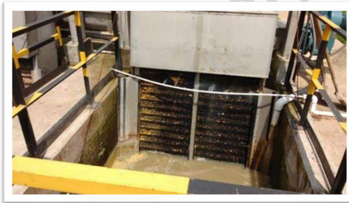
Fotografía 4. Rejilla Móvil de Cribado fino.
