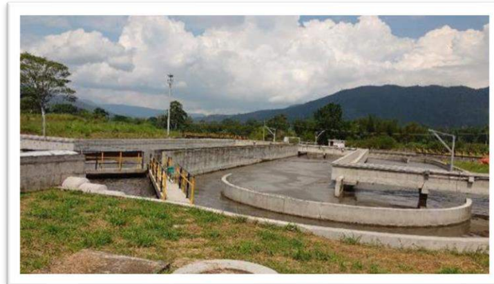
Fotografía 10. Tanques Aerobios.
