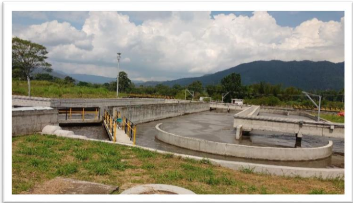
Fotografía 10. Tanques Aerobios.
