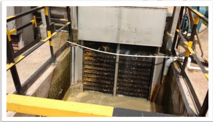
Fotografía 4. Rejilla Móvil de Cribado fino.
